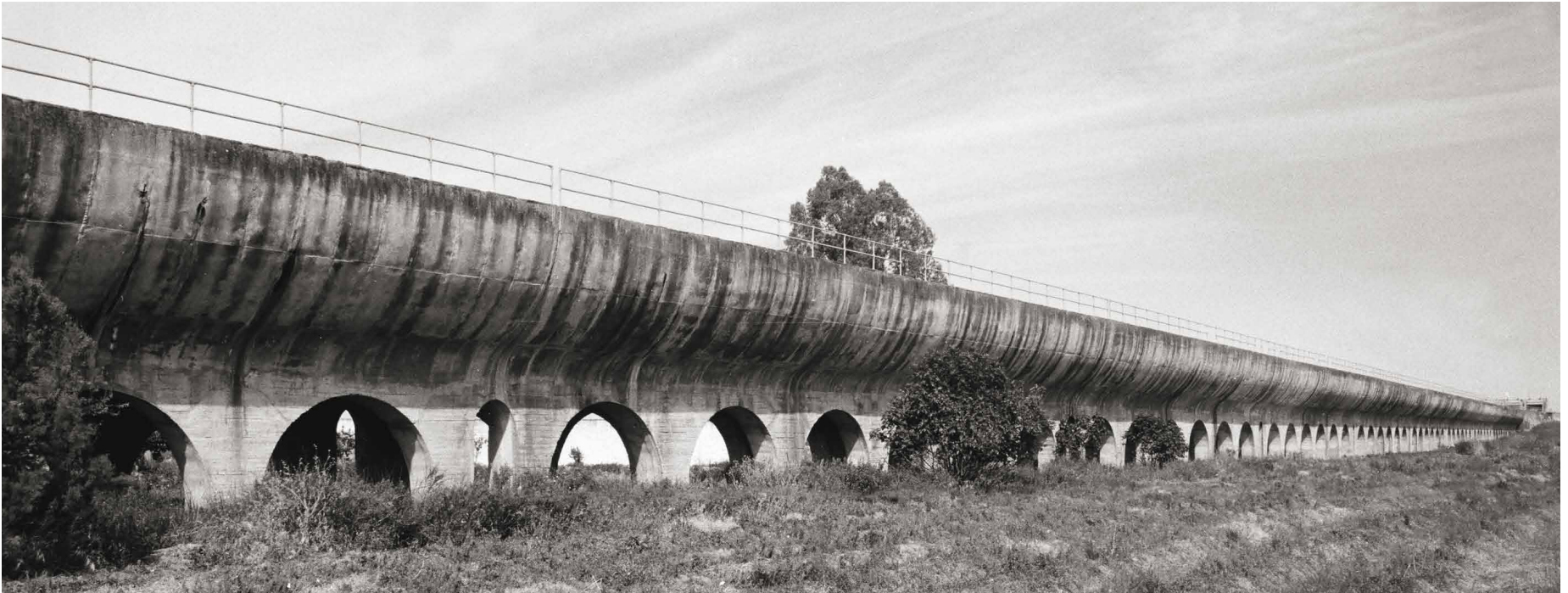
El canal en la actualidad, acueducto San Juan/ Ubidea gaur egun, San Juan akueduktua Autor / Egilea: Lolo Vasco
