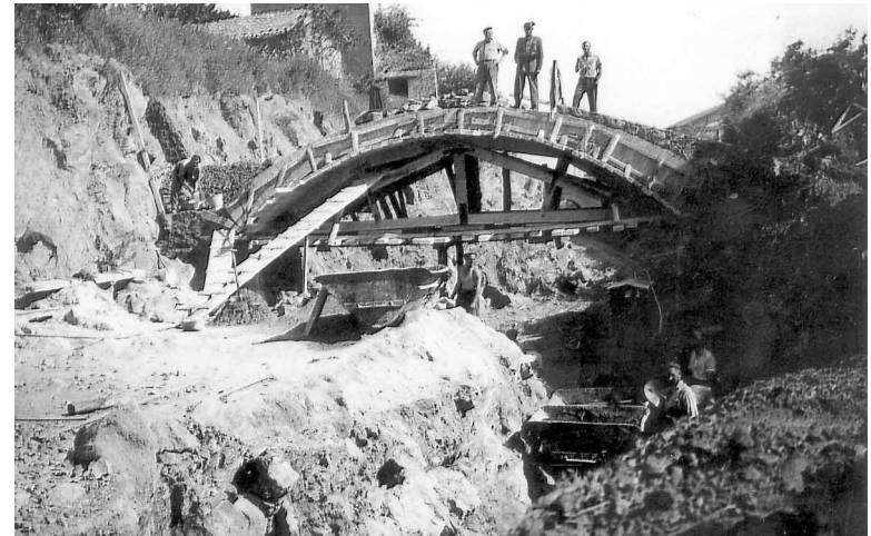
Presos y guardias civiles en las obras del Ferrocarril Sukarrieta-Bermeo / Presoak eta guardia zibilak Sukarrieta-Bermeo bitarteko trenbide lanetan
